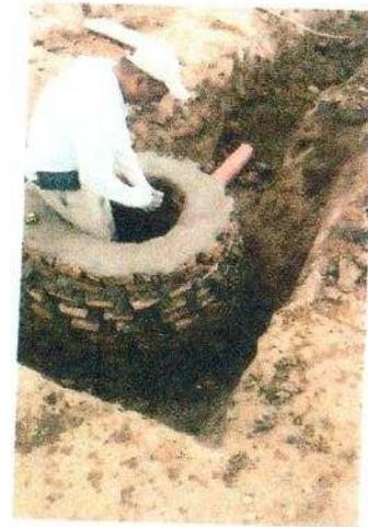
POZO DE VISITA COMUN DE 0.50 HASTA 2.00 MT DE PROF. INCLUYE: PEDACERIA APIZONADA, MAMPOSTERIA DE 3RA CON MORTERO CEMENTO ARENA 1:3, MUROS DE TABIQUE DE 28 CM APLANADO INTERIOR CEMENTO ARENA 1:3 CONCRETO F'c= 150 KG/CM<sup>2</sup>, ACERO DE REFUERZO Y ESCALONES, BROCAL Y TAPA DE CONCRETO POLIMERICO
