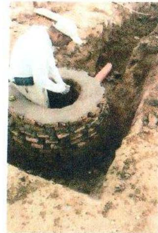
POZO DE VISITA COMUN DE 0.50 HASTA 1.00 MT DE PROF. INCLUYE: PEDACERIA APISONADA, MAMPOSTERIA DE 3RA CON MORTERO CEMENTO ARENA 1:3, MUROS DE TABIQUE DE 28 CM APLANADO INTERIOR CEMENTO ARENA 1:3 CONCRETO F'c= 150 KG/CM2, ACERO DE REFUERZO Y ESCALONES, BROCAL Y TAPA DE CONCRETO POLIMERICO
